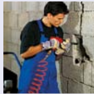
Abbruchhammer klein 156 l/min, 6-7 bar
